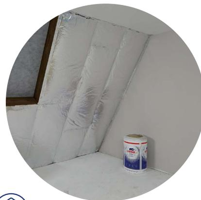
Rouleau de laine minérale revêtu sur une face d'un papier alukraft renforcé avec languettes
